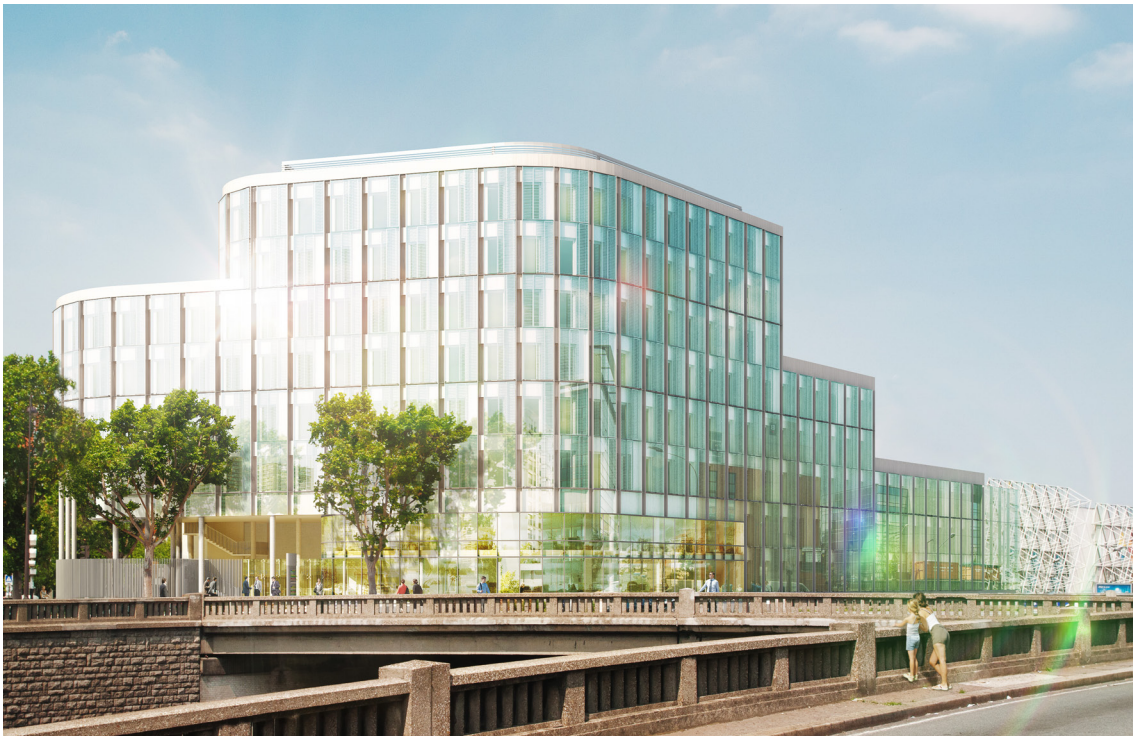
Opalia, immeuble en construction bois, avenue de la Porte d'Ivry, Paris
